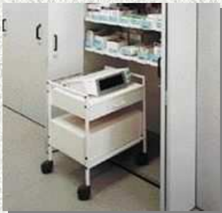
Falttüranlage befahrbar (hierzu wurde die Führungsschiene in denFußboden eingelassen)
